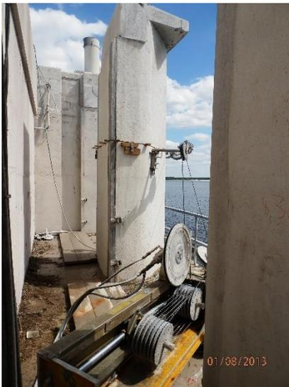
Im Zuge der Maßnahmen waren der Kranbahnträger sowie die Zwischenpfeiler bis UK Steg zu erneuern. Der Teilabbruch der alten Pfeiler erfolgte mittels Trennschneiden. Die Wiederherstellung erfolgte mit Fertigteilen, welche kraftschlüssig und lagesicher mit dem Bestand verbunden wurden. Die angrenzenden Flächen der Außenpfeiler wurden mittels Spritzbeton (bewehrt und unbewehrt) saniert. Hierfür wurden folgende Ingenieurleistungen erbracht.
