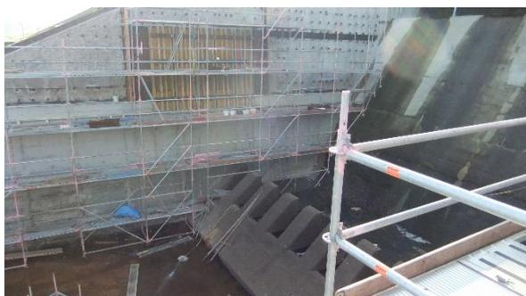
Die Tosbeckenrandmauern umgrenzen das Tosbecken zwischen den beiden Überfallblöcken als teilweise bewehrte Gewichtsmauer. Im Tosbeckenbereich befinden sich die Ausläufe aus den Grundablässen und der Turbine. Die Geamtlänge der Ost- und Westseite beträgt jeweils etwa 64 m. Die Höhe der Randmauern über Tosbeckensohle steigt von etwa 7 m auf 16 m an.
