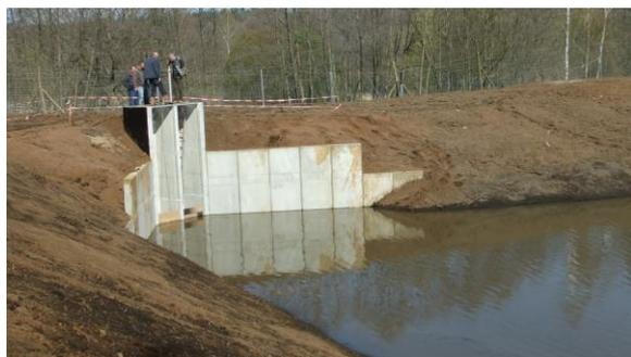
Die Ablagerungsbecken für Sedimente aus der Vorsperre Bühlow befinden sich in den Vorlandbereichen der Spree und bestehen aus etwa 5 m hohen Ringdämmen. Die Becken wurden beräumt und für den Klarwasserabzug neue Mönchbauwerke errichtet.
