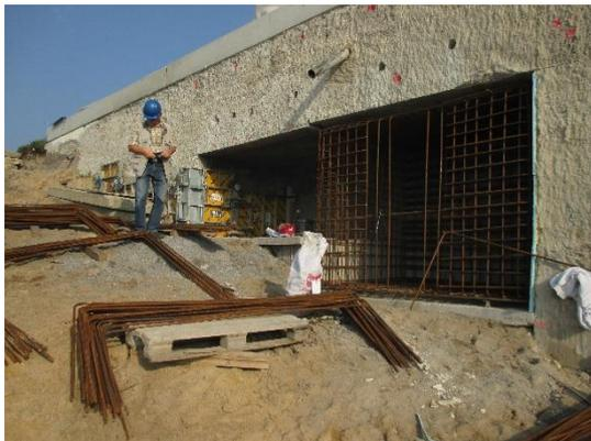
Die Maßnahme umfasste die Sanierung der Betonoberflächen mittels bewehrtem und unbewehrtem Spritzbeton sowie den Neuaufbau des Wasserbaupflasters auf den angrenzenden Böschungskegeln (1200 m<sup>2</sup>) von den Außenpfeilern bis zum Böschungsanschluss.
