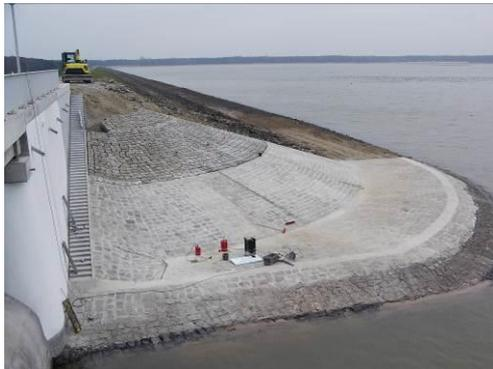
Die TS Spremberg ist ein Flachlandspeicher mit 9,6 km<sup>2</sup> Stauffläche und einem Gesamtstauraum von 40,9 Mio m<sup>3</sup>. Das Absperrbauwerk bildet ein 3,7 km langer Erddamm mit Grundablass- und HW-Entlastungsbauwerk. Die Sperre wurde von 1958 bis 1965 errichtet. Auf Grundlage des Berichtes zur vertieften Überprüfung (2004) wurde die Generalsanierung der Sperre in Angriff genommen. Folgende Teilobjekte wurden bis dato geplant und umgesetzt:
