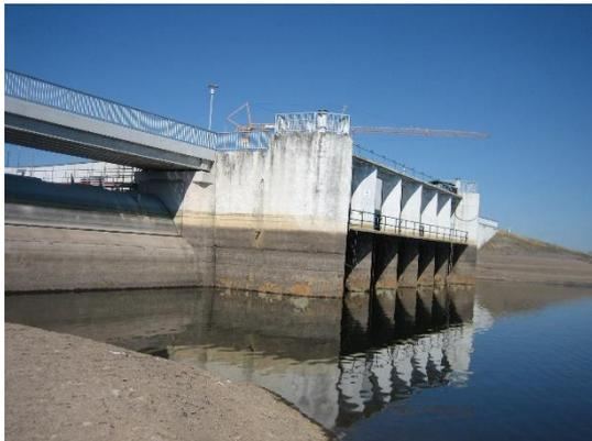
An den Enden des Entlastungsbauwerks befinden sich die Flügelmauern, im Anschluss daran zur Mitte des Bauwerks die Überfallblöcke mit je einer Stauklappe. Zwischen den beiden Stauklappenblöcken gibt es zwei Außenpfeiler sowie 5 Zwischenpfeiler. Die äußeren Flügelmauern bestehen aus einer Kernmauer mit aufgesetztem Fahrbahnüberbau. Wasserseitig ist an dem Überbau bereichsweise eine vorgehängte Wand vorhanden. Der Zwischenraum war hohl.
